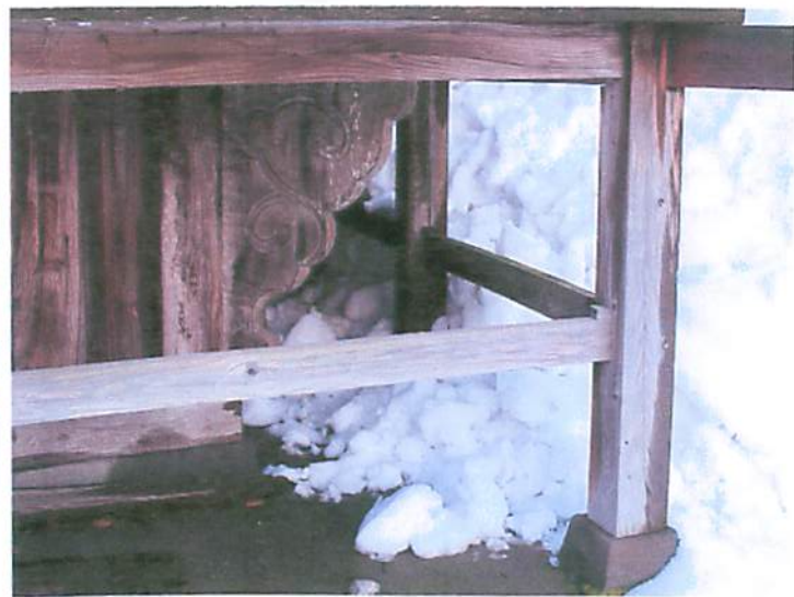
拝殿床下持送り
